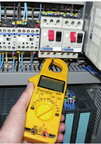
↑ Figura 3.10. Proceso de medida con pinza amperimétrica.
